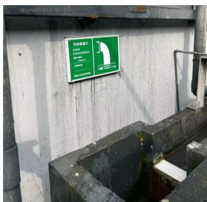
污水排放口标识
