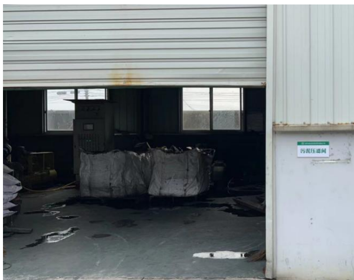
污泥压滤间照片
